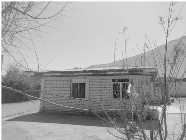
Casa de Reforma Agraria, Valle de Lluta
